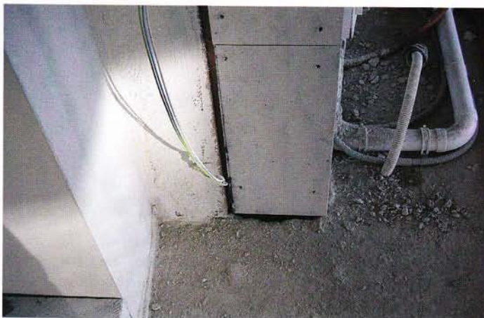
■ Aus dem Schacht führen Versorgungsleitungen. Daher ist keine Brandabschottung gegeben. Grundsätzlich sind fremde Bauteile in Abgasschächten nicht gestattet.
