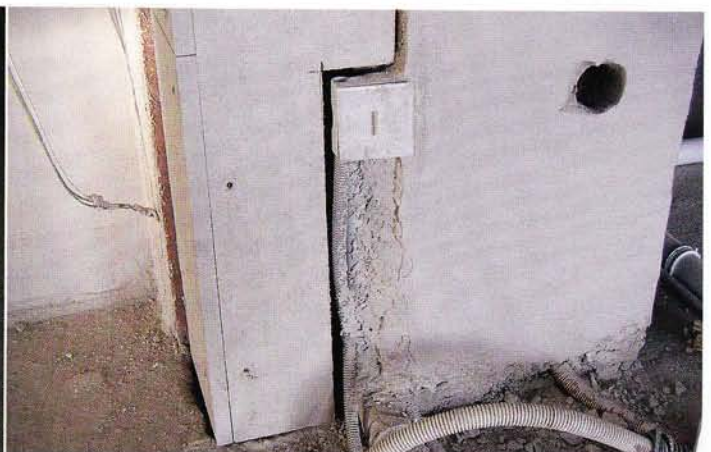
■ Aus dem Schacht führen Versorgungsleitungen. Daher ist keine Brandabschottung gegeben. Grundsätzlich sind fremde Bauteile in Abgasschächten nicht gestattet.
